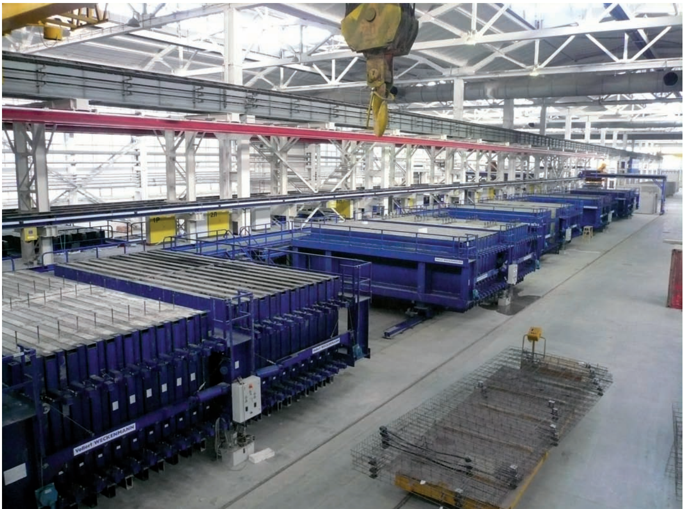
Abb. 1: Die Steuerungstechnik für die Vibration von fünf Batterieschalungen mit fast 500 Rüttlern ist auf einer Reling in 4 m Höhe installiert. Alle fünf Bedieneinheiten können sich ohne Umschalten gegenseitig ersetzen (Redundanz).
