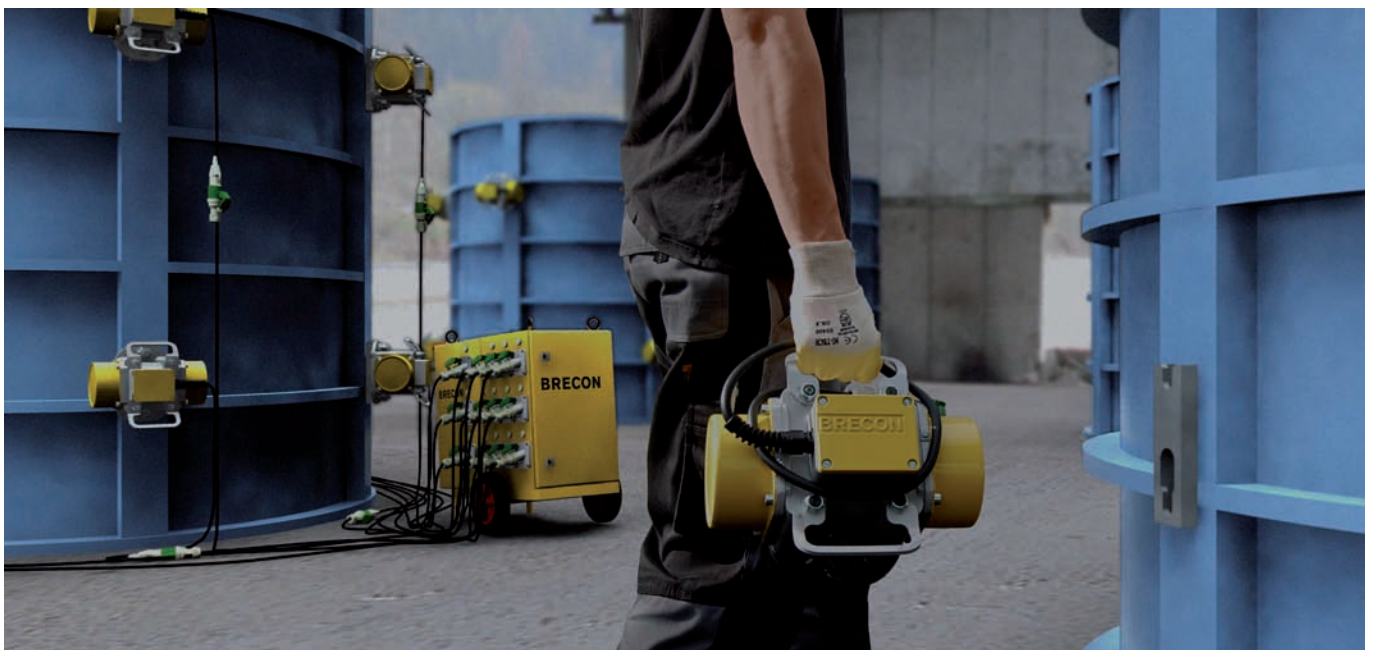
Le vibreur à serrage rapide Slim2 intégré à un système mobile de vibration
