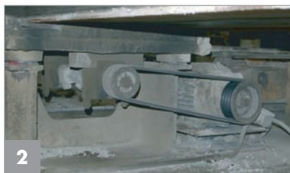
Ancienne unité de compactage à entraînement par courroies trapézoïdales
