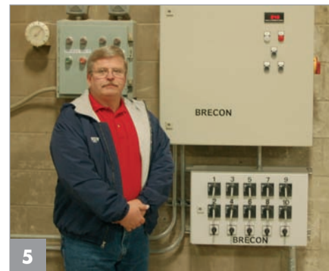
Randy Molin, responsable d'usine, à côté de la nouvelle armoire de contrôle de vibration
