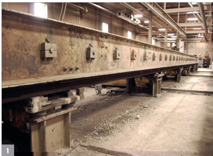
Ligne de production Flexicore chez Molin Concrete, dans le Minnesota
