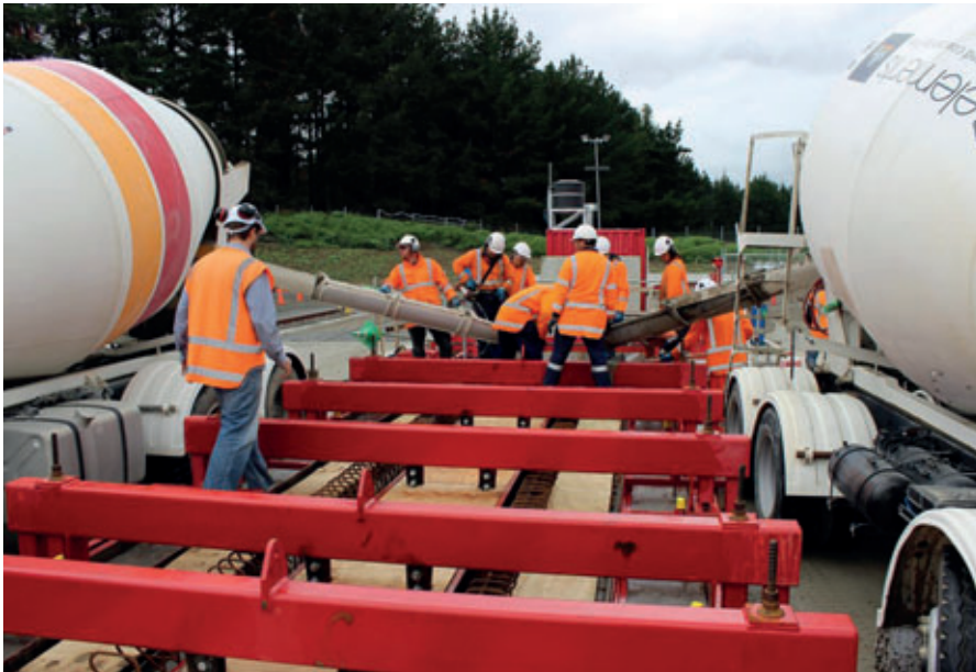
Vorbereitung zum Betonieren des ersten Super-T-Trägers
