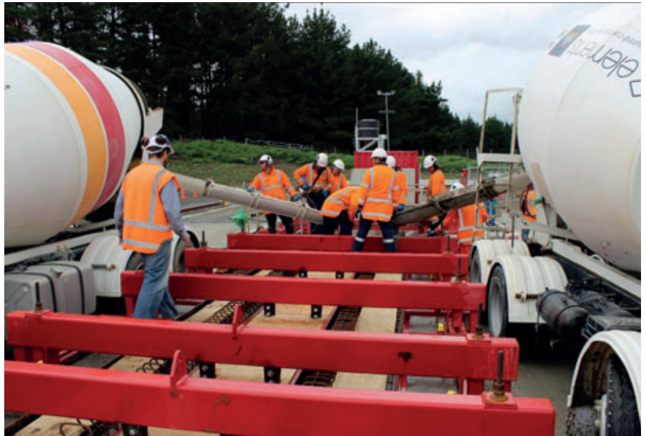
Preparing for the first super tee pour
