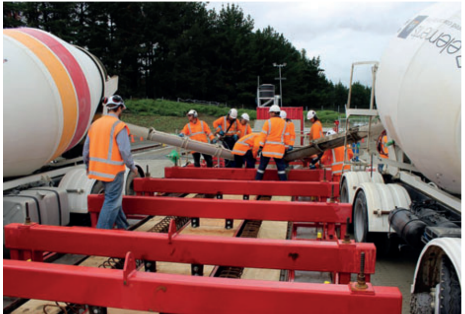
Préparatifs en vue du coulage de la première super poutre en T
