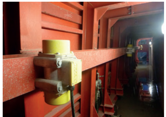
Coffrage après les modifications
