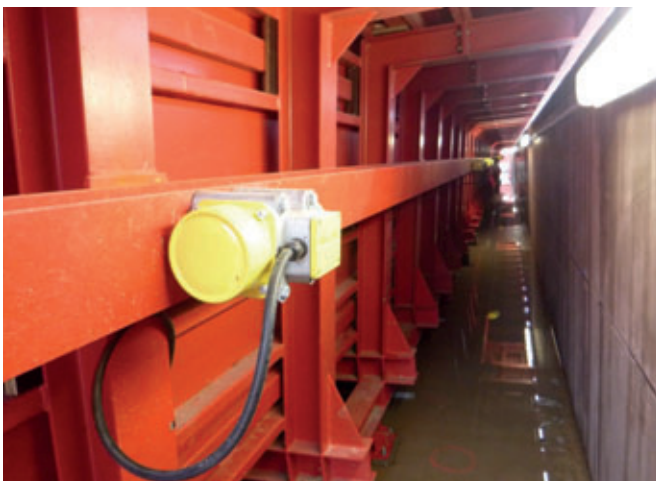
Coffrage avant les modifications
