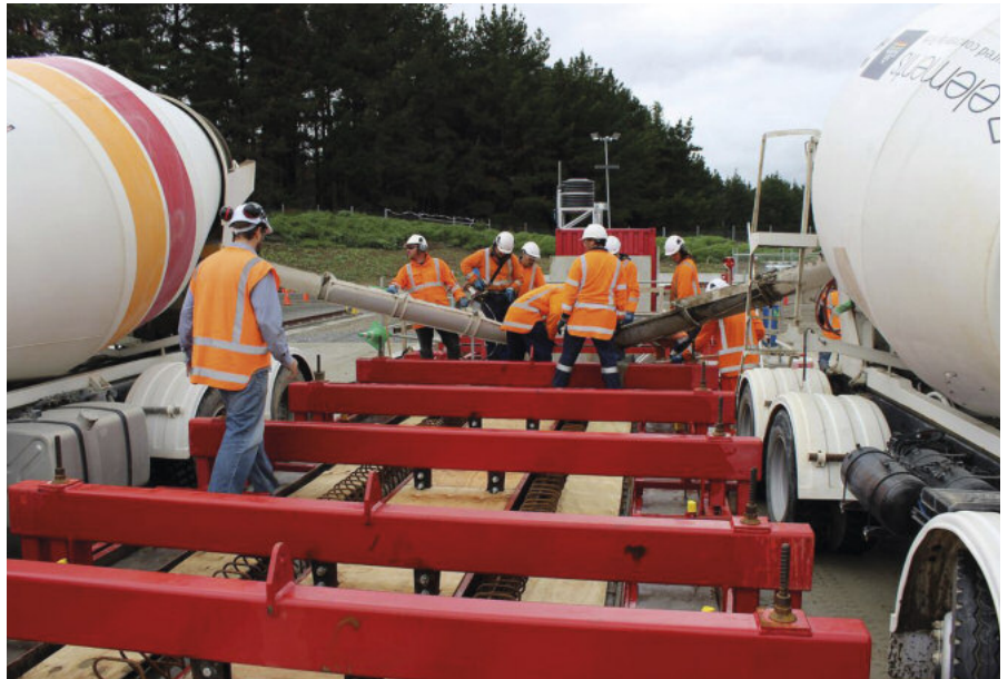
Początek betonowania pierwszej belki teowej.
