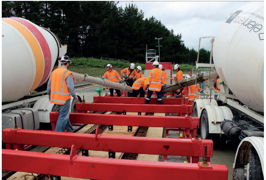
Подготовка к бетонированию первой крупногабаритной тавровой балки
