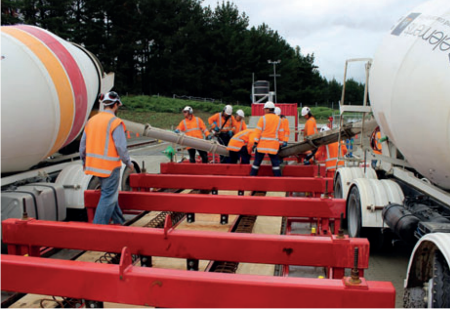
İlk süper T-kirişinin dökülme hazırlığı
