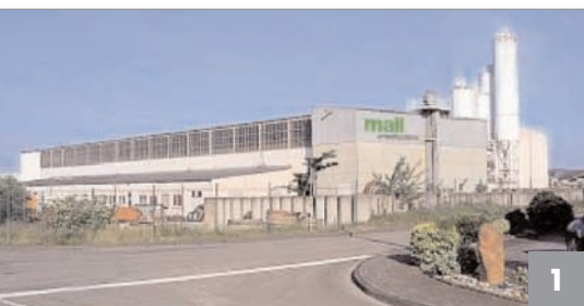
Le nouveau site de production de l'entreprise Mall à Nottuln, en Allemagne
