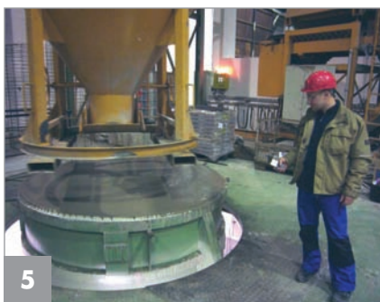
5 Contrôle du processus de compactage par télécommande
