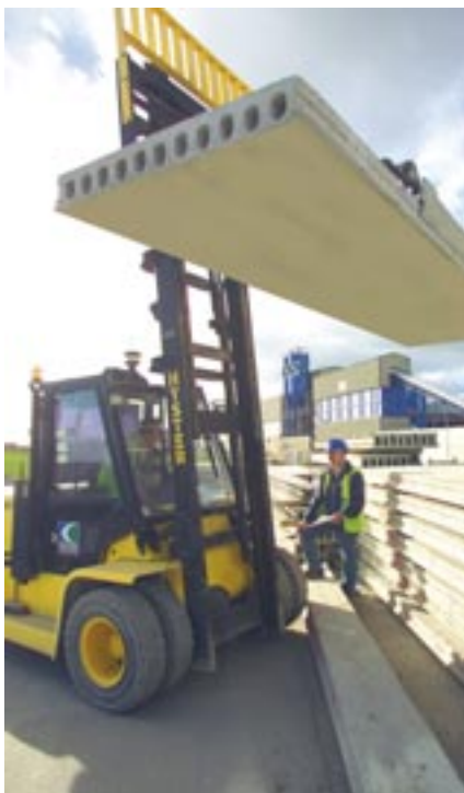
Plac składowy z płytami kanałowymi w Ardboe.
