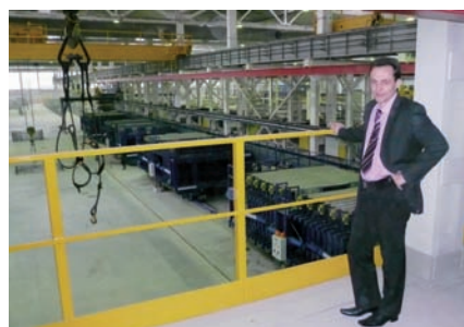
Fig. 10: Le chef de projet Alexandre D. Jaroschenko de DSK Blok se félicite d'une installation propre et bien disposée.
